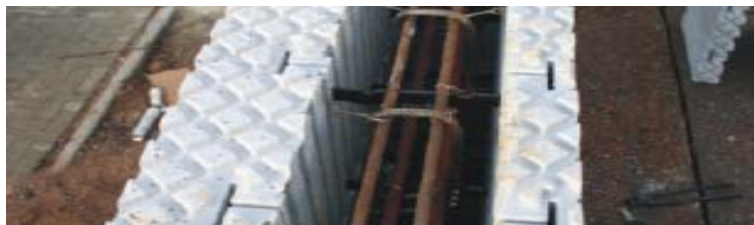
Figure 7 - Exemple de positionnement de ferrailage sur l'entretoise MAGU
