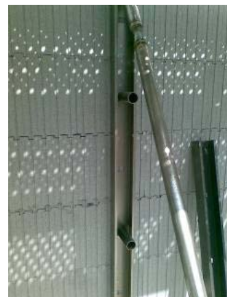
Figure 14 - Photo d'un stabilisateur MAGU en étaie
