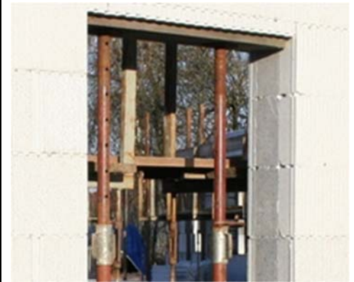
Figure 12 - Photos illustrant la réalisation des linteaux
