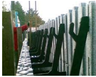
Figure 15 - Photo illustrant la réalisation du coffrage des rives de planchers
