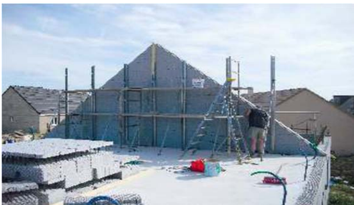
Figure 13 - Photo illustrant la réalisation du coffrage d'un pignon avec pose d'étais
