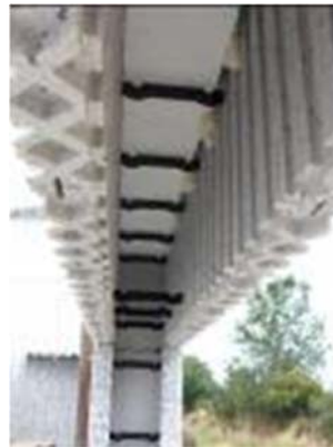
Figure 12 - Photos illustrant la réalisation des linteaux
