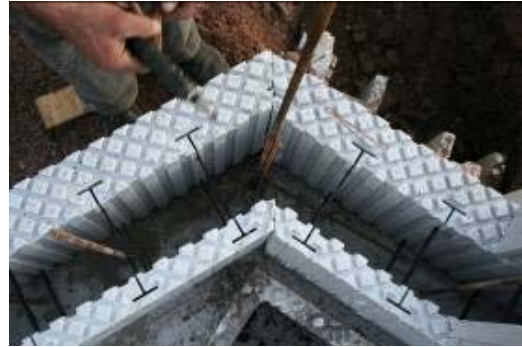
Figure 10 - Photos illustrant la réalisation des angles spécifiques
