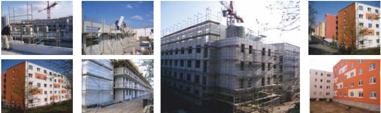
ENSEMBLE DE 478 APPARTEMENTS pour étudiants à Mayence
