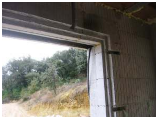
Pose en feuillure
