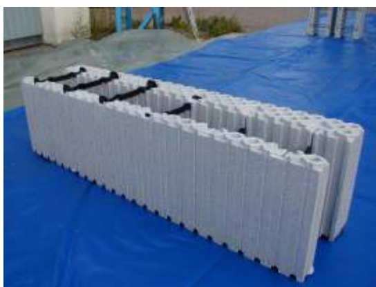
Assemblage des entretoises de la partie inférieure
