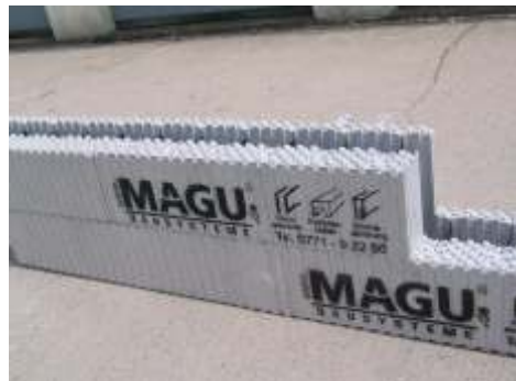
L'assemblage des blocs se réalise toujours à joints croisés, le chevauchement est au minimum de 20cm
