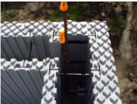
Démarrage sur la dalle dans un angle, la pose se fait à sec directement sur la dalle.
