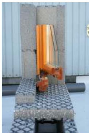
Pose en tunnel
