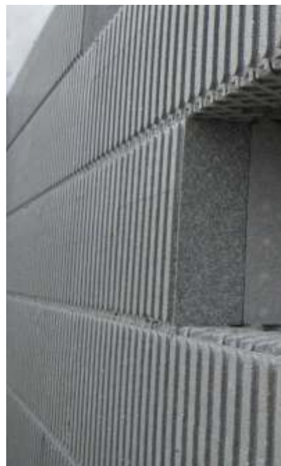
Finition queue arrondie pour enduit épais
